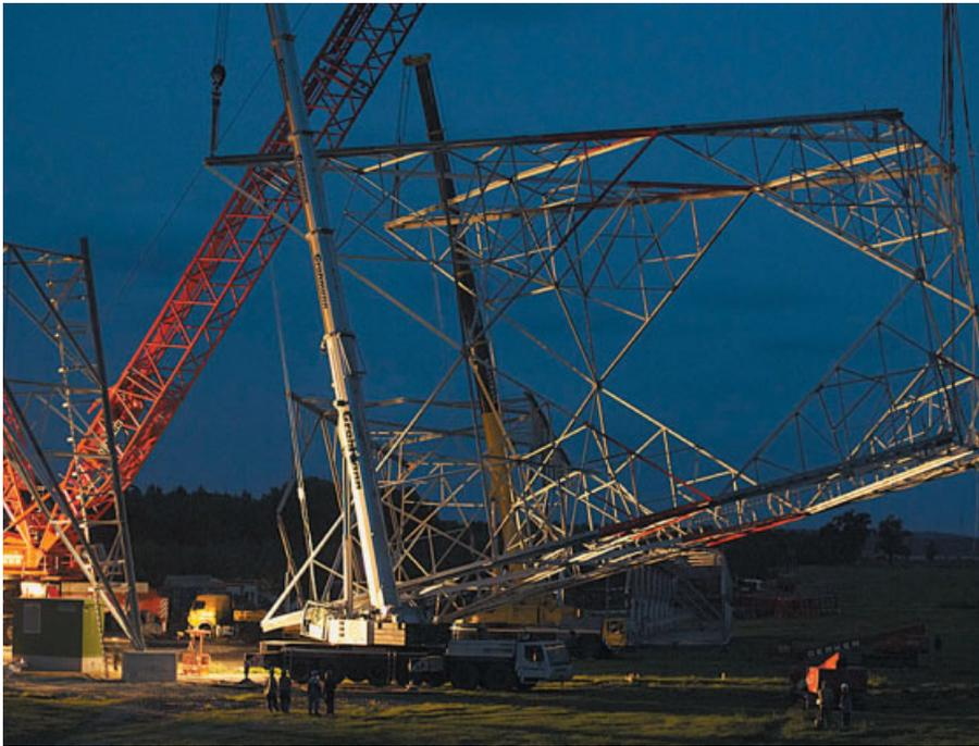
Bild 11. Montage des größten Segmentes mit 100 t
