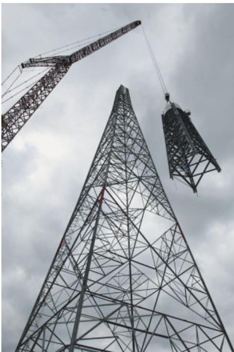
Bild 12. Montage des Gitterturmkopfes mit Zylinder
