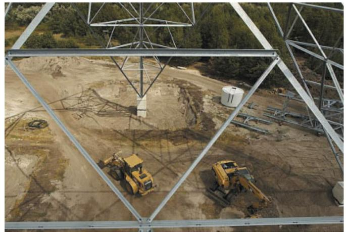
Bild 10. Fundament kurz vor der Fertigstellung, Platte mit Erde überdeckt
