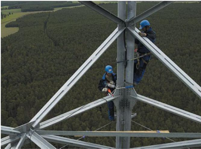
Bild 8. Eckstielstoß mit HV-Schrauben als GV-Verbindung, während der Montage
